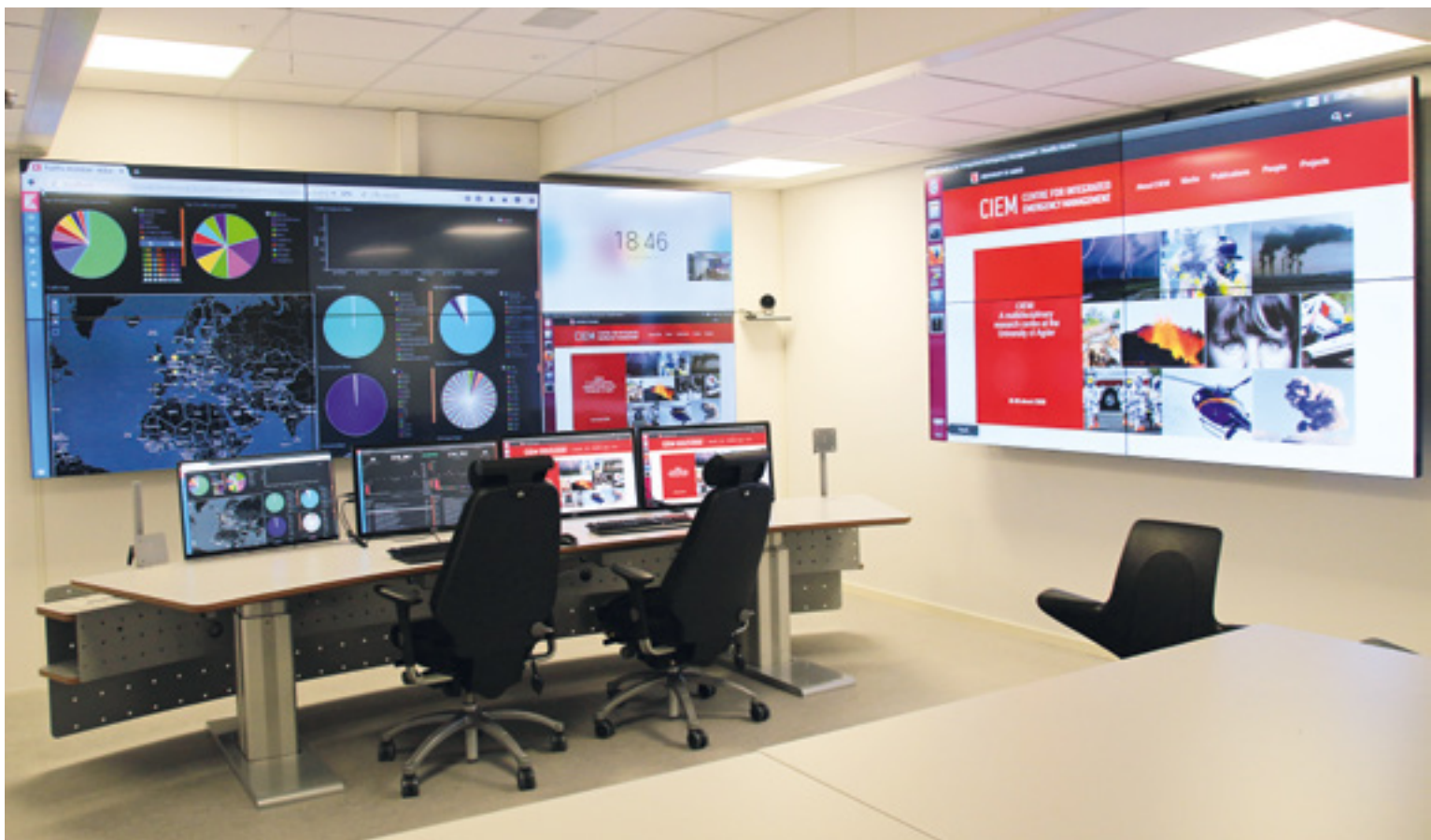
Kontrollrommet er utstyrt med 11 monitorer, og gir god mulighet til å ha oversikt over krisesituasjonen og håndtere informasjonsstrømmen.
